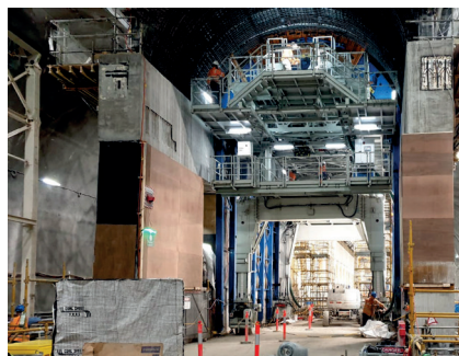
Cassero di galleria in cantiere
